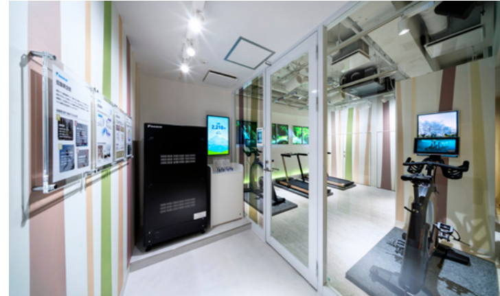
画像提供：御園生大地 撮影者：御園生大地
